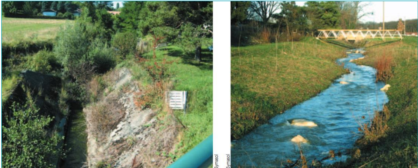
Le secteur 1 de l'Hermance : à gauche, l'Hermance recalibré avant travaux en août 2008 ; à droite, l'élargissement de la section du lit mineur et la plantation en berges, vue en décembre 2009.
