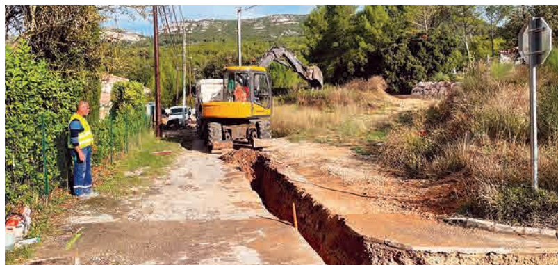
Travaux de réfection de la voirie, création d'un pluvial et modernisation de l'éclairage public chemin de Coutran - Coût : 145 000 € (subvention CD13 50%)
