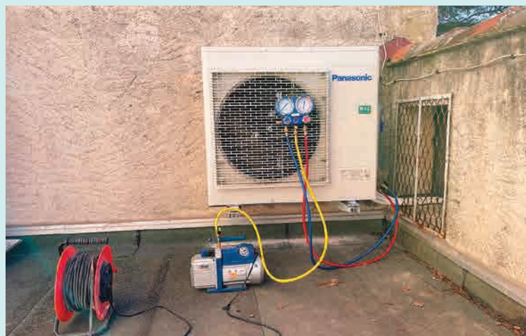
Remplacement d'une chaudière fioul par une pompe à chaleur au Centre Culturel - Coût : 20 000 €.
