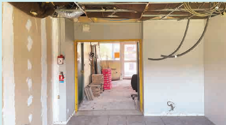
Rénovation et réaménagement des services techniques de la ville Coût : 81 000 € (subvention CD13 70 %)
