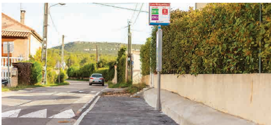
Rénovation et mise en accessibilité de l'arrêt de bus des Roquettes (financement Métropole). Création d'un trottoir – Coût : 28 000 € (subvention CD13 50%)
