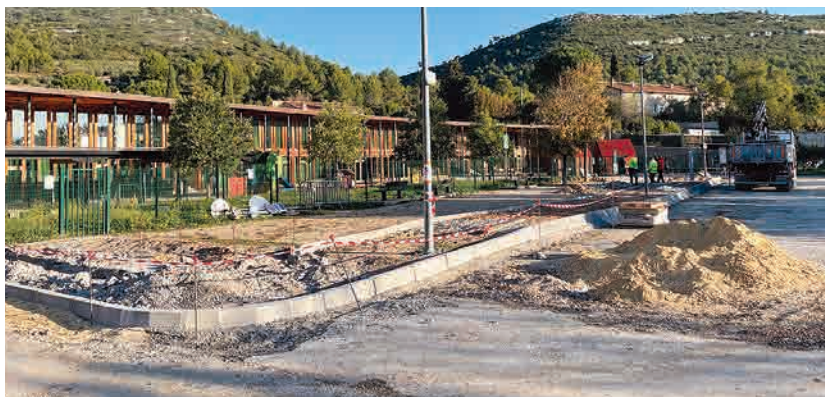
Création d'un quai accessible dédié au transport scolaire à l'école des Hameaux (financement Métropole)
