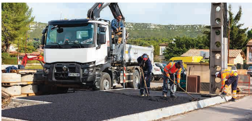
Réfection du parking des Roquettes et mise en sécurité de l'arrêt de bus sur le parking (financement Métropole)
