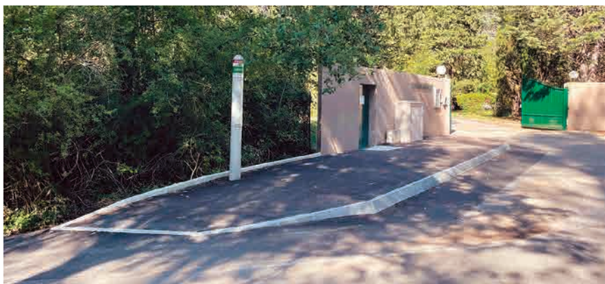
Mise en accessibilité de l'arrêt de bus à proximité de Médiatur (financement Métropole)
